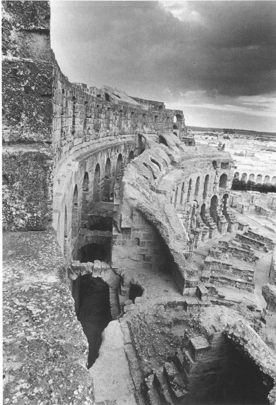
Amphithéâtre d'El Djem. Structure interne de la cavea. Photo A.M. Camps
